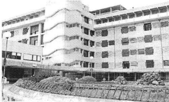
Al via i lavori di adeguamento delle sale operatorie di Ortopedia
